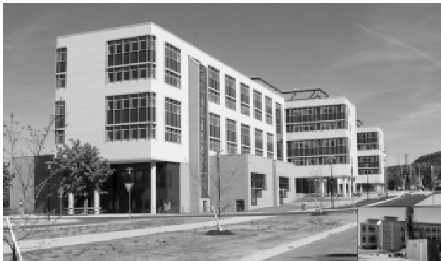
1. Teil des Physik-Neubaus fertiggestellt; 2. Teil in Angriff genommen (r.u.)
