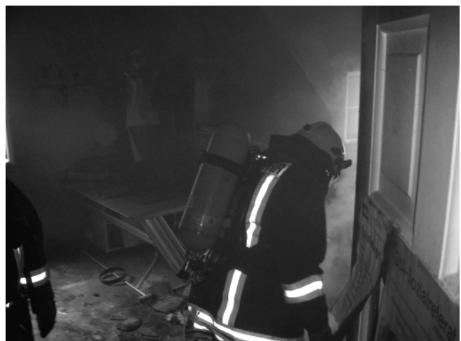
Sozialreferat ausgebrannt: Unter Atemschutz versucht die Feuerwehr den Schwelbrand in der Zwischendecke zu löschen.
