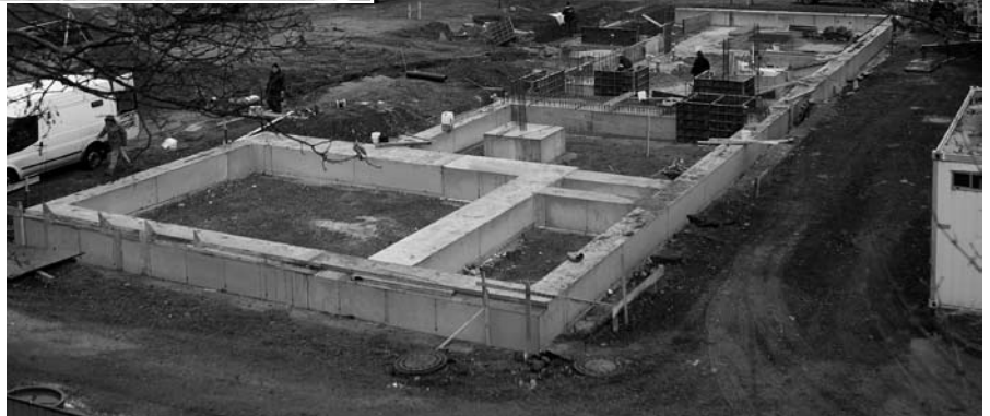
... stehen mittlerweile die Fundamente.
