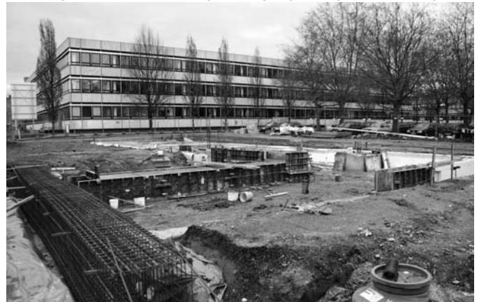
Die Fundamentarbeiten schreiten voran.
